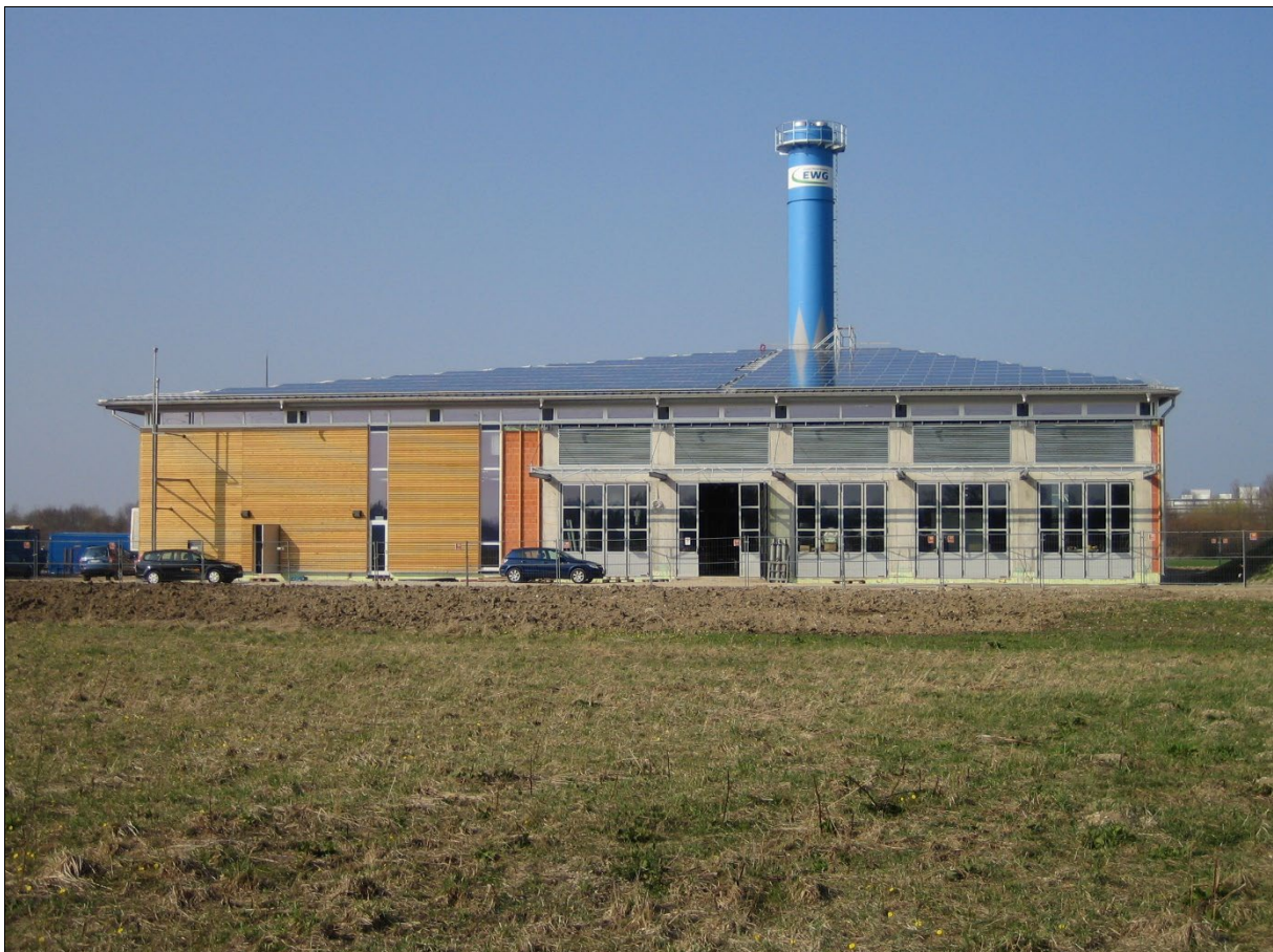
Abbildung 12: Geothermieheizzentrale Garching (Foto Stadt Garching, Mai 2011)
